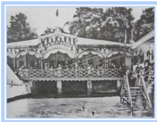
IMAGEN DE LA CUBIERTA: Casa de Baños "La Iniciadora" Fotografía: Pacheco Archivo Pacheco
