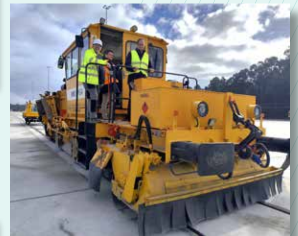
Carlos Botana visita las obras del apartadero ferroviario de la PLISAN, que avanzan a buen ritmo
