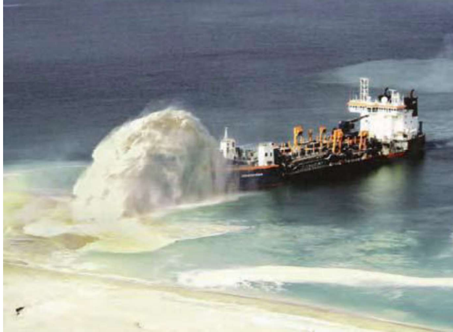
Draga de succión en marcha bombeando mezcla de agua y productos de dragado en la formación de un relleno
