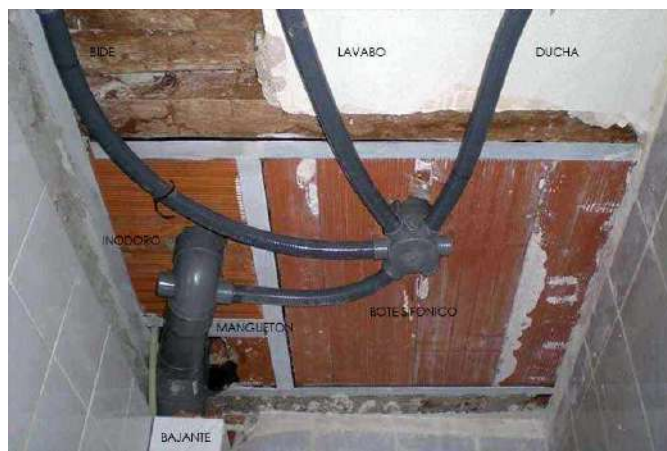
Fig. 49 Desagüe con bote sifónico.
